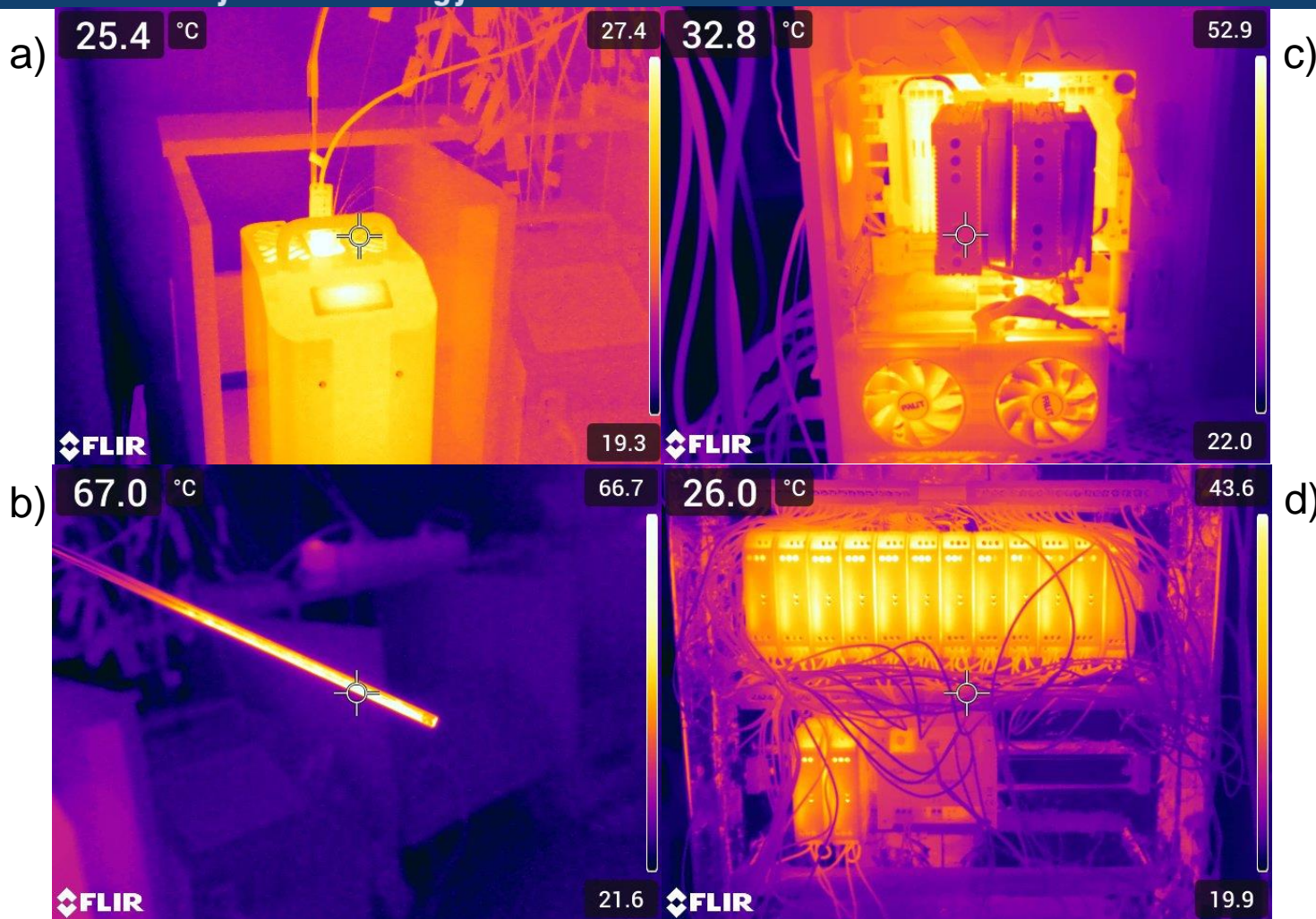
Termogramy a) piecyk kalibracyjny WIKA CTD9100-ZERO, b) termoelement RTD PT-100, c) wnętrze komputera, d) wnętrze skrzynki elektrycznej z kondycjonerami.
